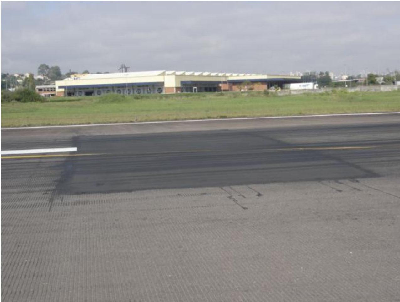
Grande reparo na zona de toque da cabeceira 29.
